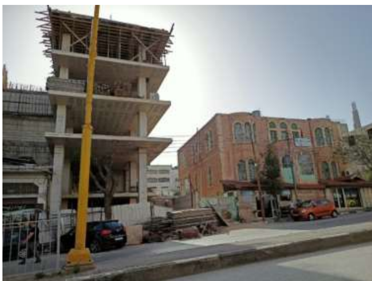
(لوحة ٦) صور توضح الهدم جزئي للمبنى نتيجة الحفريات للبناء التجاري الملاصق للمبنى القديم حيث انهارت زاوية المبنى نتيجة الاهتزازات الناجمة من الحفريات المجاورة. © تصوير الباحث، ٢٠٢١.
