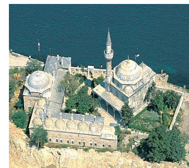
(لوحة ٨) سقيفة جامع شمسي أحمد باشا بإستانبول على شكل حرف (L) https://www.archnet.org/publications/1511 Accessed at 1/2022
