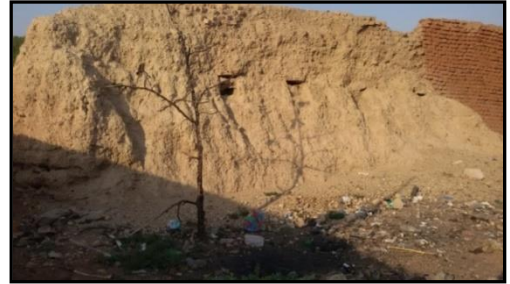
لوحة رقم ٣٤ بقايا الجدار الجنوبي لطابية السرحة الجنوبية. تصوير الباحثة.
