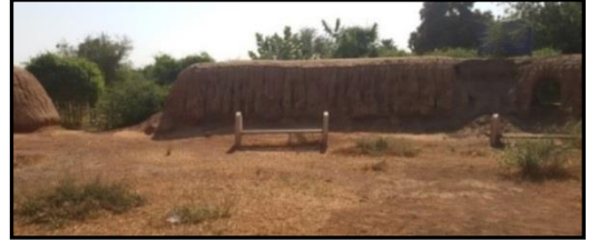
لوحة رقم ٣ المسافة بين المدخل الرئيسي وفتحة المراقبة الجنوبية الغربية من داخل طابية توتي الشمالية، تصوير الباحثة.
