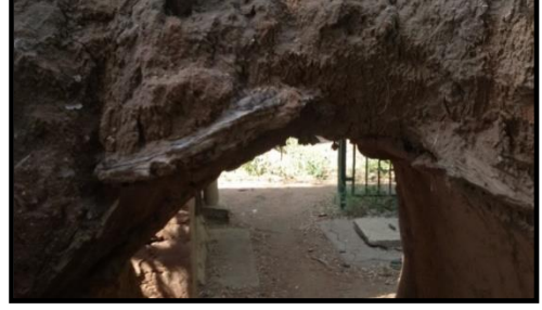
لوحة رقم ٥٠ فتحة المراقبة الشمالية في طابية شمبات واستخدام الأخشاب كعتب. تصوير الباحثة.
