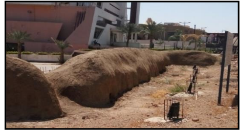
لوحة رقم ٢٢ الجناح الجنوبي والجزء المتعامد عليه لطابية الملازمين الشمالية من الداخل. تصوير الباحثة.
