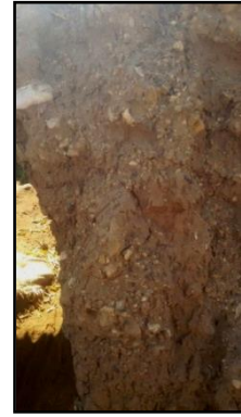
لوحة رقم ٩ استخدام الحصى وقطع الأحجار في الكتف الأيمن لفتحة المراقبة الجنوبية الغربية في طابية توتي الشمالية. تصوير الباحثة.
