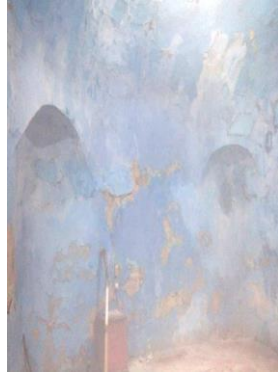
(لوحة ١٤) منطقة انتقال القبة التي تغطي بيت أول
