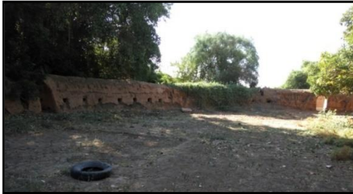
لوحة رقم ٤٧ المسافة بين فتحة المراقبة الجنوبية والفتحة الغربية لطابية شمبات. تصوير الباحثة.
