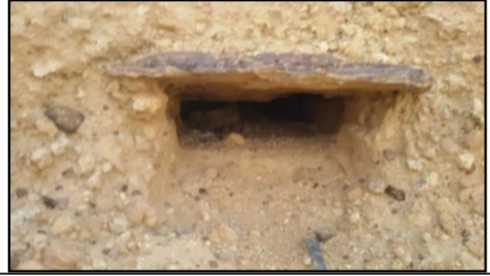
لوحة رقم ٣٢ استخدام الحجر كعتب لفتحات المزاغل، طابية السرحة الشمالية. تصوير الباحثة.
