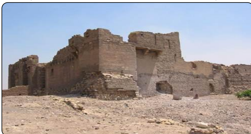
لوحة (٩) الواجهة الجنوبية الغربية للخانقاه النظامية من الداخل (تصوير الباحث)
