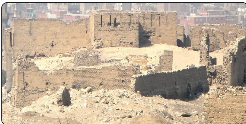
لوحة (٦) الواجهة الجنوبية الشرقية للخانقاه النظامية من الخارج (تصوير الباحث)
