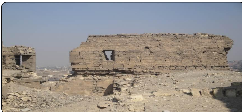
لوحة (١١) الواجهة الشمالية الشرقية للخانقاه النظامية من الداخل (تصوير الباحث)
