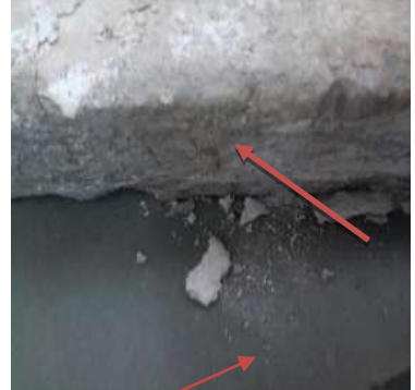
صورة (٨) توضح تفتت وسقوط أجزاء من اللوحات
