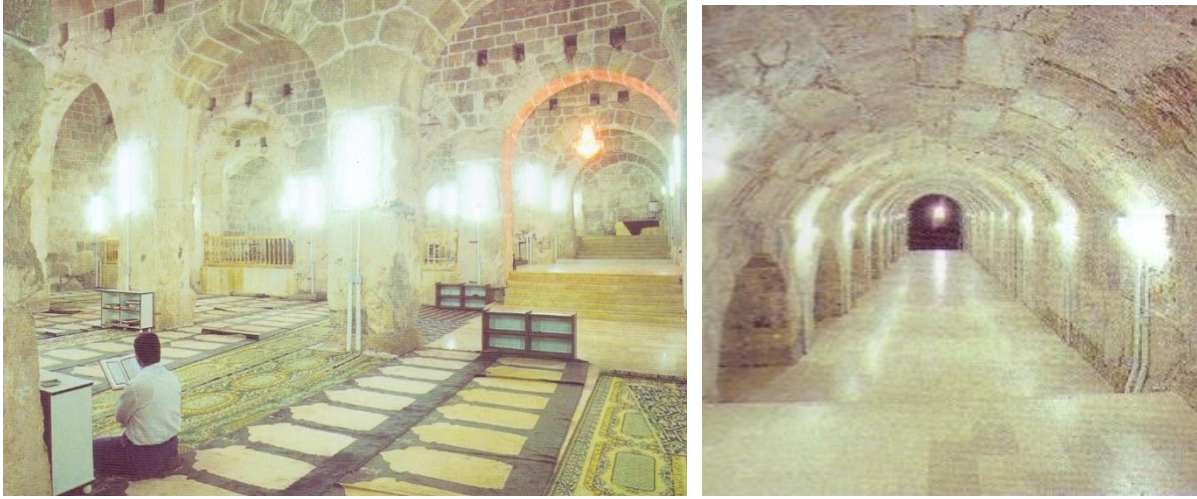
(لوحة ٤) توضح بناء ظلّة القبلة بالمسجد الأقصى على حوائط حاملة
