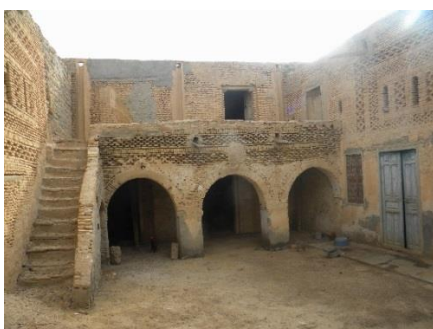
لوحة (٢٠) منزل الهاشمى الواجهة الجنوبية للصحن الأكبر © تصوير الباحث.
