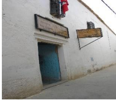
(لوحة ٢) منزل الوادى الواجهة الرئيسية بها كتلة المدخل © تصوير الباحث.
